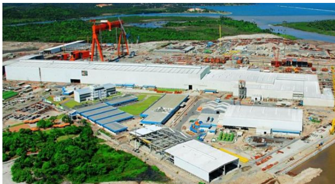
ESTALEIRO ATLÂNTICO SUL 120.000 m 2 Porto de Suape - PE
