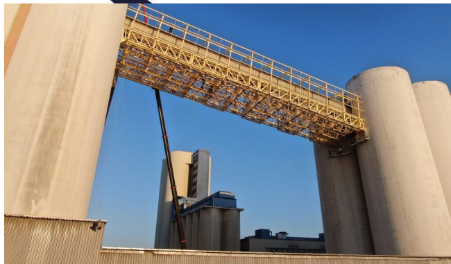
PASSARELA MUCURIPE - M DIAS BRANCO - M.DIAS 40m de comprimento / 40m de nível do solo Fortaleza - CE
