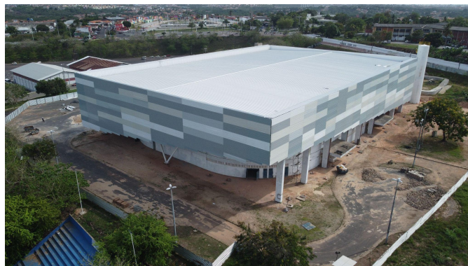
GINÁSIO CASTELINHO - GINÁSIO CASTELINHO 6.000 m 2 São Luís - MA
