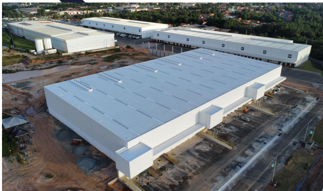
GALPÃO MERCADO LIVRE - GRUPO CANOPUS 10.290,54 m 2 São Luis - CE
