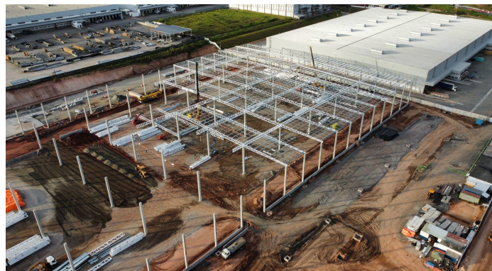
CEL SUAPE - CEL SUAPE 33.600 m 2 Cabo de Santo Agostinho - PE
